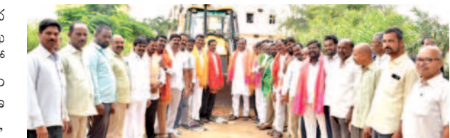
మేధుల్లో సీసీ రోడ్డు నిర్మాణ పనులను ప్రారంభించిన మంత్రి మల్లారెడ్డి
